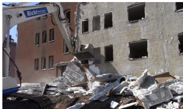
Abbildung 5: Selektiver Rückbau einer Gebäudefassade im Kanton Zürich. (Quelle: ERM)
