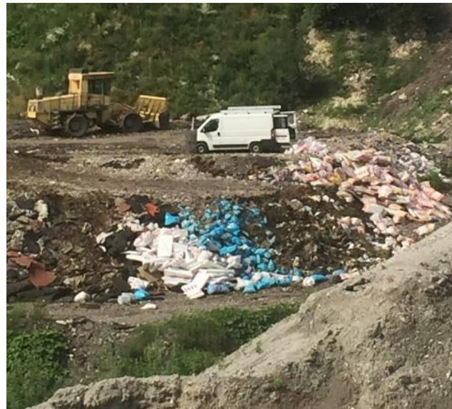
Abbildung 9: Auf einer Reaktordeponie werden teilweise noch verpackte Dämmmaterialien deponiert. (Quelle: ERM).
