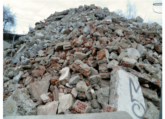
Fig. 2: Mischabbruch aus Gebäuderückbau (Foto: D. Hiltbrunner).
