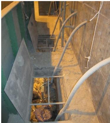
Abbildung 1: Zugabe der sauer gewaschenen Asche durch 4 Rohrleitungen über die gesamte Breite des Einfülltrichters der ReFire-Ofenlinie.
