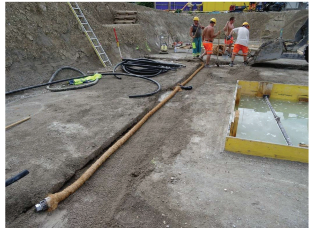
Rohre und Kofferrung für Absaugung
