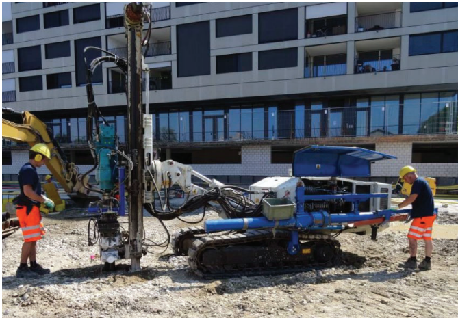
Bohrungen für Injektionslanzen
