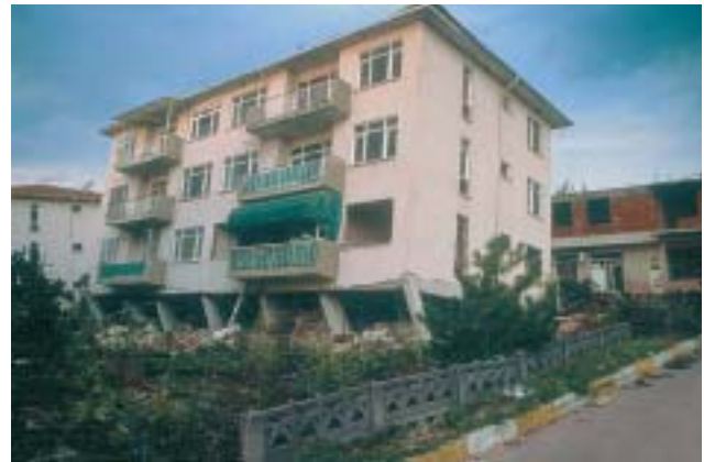
4/3 Hier stehen die vorderen Stützen – in ihrer schwächeren Richtung – schief, die hinteren haben ganz versagt (Izmit Türkei 1999).
