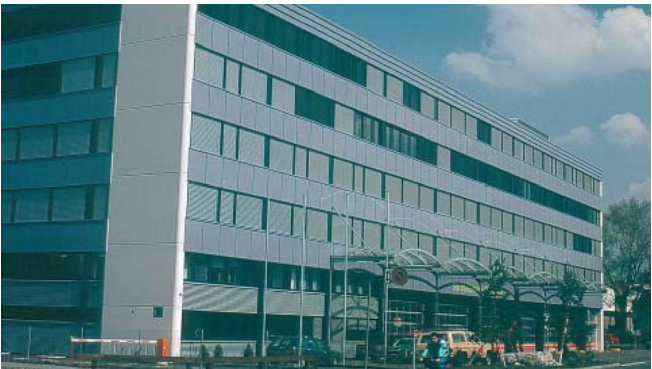
9/4 Die Tragwände wurden als markantes Element in die architektonische Gestaltung miteinbezogen (Schweiz 1994).
