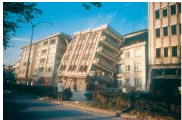
30/2 Das schief stehende Gebäude ist ungleichmässig abgesunken und lehnt sich gegen ein Nachbargebäude (Izmit Türkei 1999).
