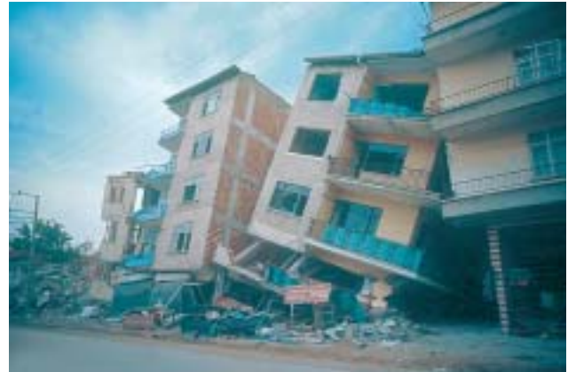
4/2 Ein Stützenmechanismus ist bei weichen Erdgeschossen oft unvermeidlich (Izmit Türkei 1999).
