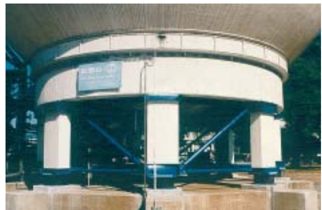
31/2 In die 8 Stahlbetonstützen wurden Erdbebenlager aus hochdämpfendem Gummi mit einem Durchmesser von 60 cm und einer Höhe von rund 30 cm eingebaut.
