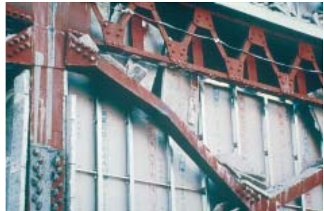
18/1 Diagonalstäbe mit Breitflanschquerschnitt sind um ihre schwache Achse geknickt ...
