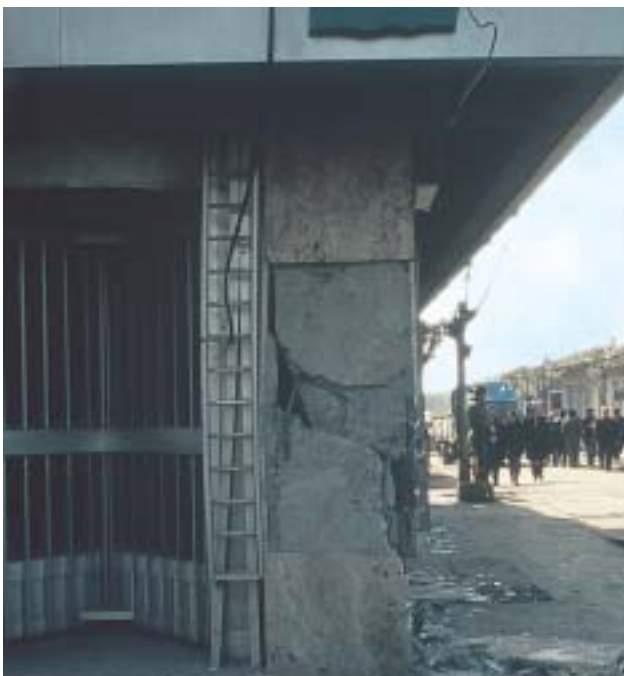
16/2 Hier wirkten die Mauerwerkspfeiler im Erdgeschoss eines Restaurants als kurze gedrungene Stützen. Sie wurden durch Schrägrisse stark beschädigt (Umbrien Italien 1997).
