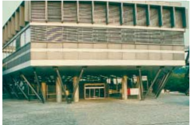
6/5 Bei diesem bestehenden Hörsaalgebäude der ETH Zürich im Campus Höggerberg befand sich im ursprünglichen Zustand aus den 70er Jahren die einzige Aussteifung gegen horizontale Kräfte und Verschiebungen in Form von torsionsweichen Stahlbetonwänden am hinteren Gebäudeende. Wegen der beträchtlichen Exzentrizität zum Zentrum der grossen Gebäudemasse hätte sich auch für das relativ schwache Bemessungsbeben (Zone 1 nach SIA 160) das Gebäude im Grundriss verdreht. Die wenigen und hoch belasteten Stahlbetonstützen im Erdgeschoss hätten vor allem im vorderen Gebäudebereich erhebliche Verschiebungen erfahren. Für die erforderliche Duktilität der Stützen war jedoch deren konstruktive Durchbildung nicht genügend. Daher wurden auf drei Seiten des Gebäudes aussen liegende Stahlstützen in Form eines Fachwerks angeordnet, dessen horizontale Scheibenkräfte infolge Erdbeben die bestehende Foundation problemlos übernehmen kann. Mit dieser Ertüchtigungsmassnahme konnte gleichzeitig auch die erforderliche Sanierung der Auskragungen für Schwerelasten vollzogen werden.
