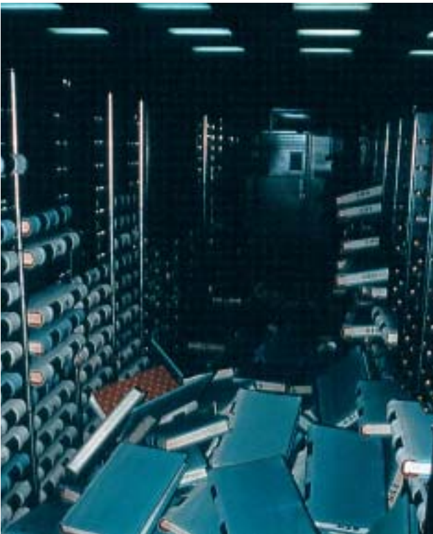
35/5 Offene Büchergestelle entleeren sich bei jedem starken Erdbeben. Wertvolle Bücher können durch nach hinten geneigte Tablare oder durch Haltestäbe gesichert werden (Loma Prieta Kalifornien 1989).
