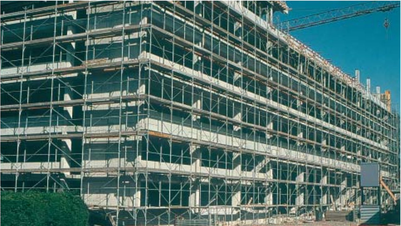
9/3 Dieser Skelettbau mit Flachdecken hat an zwei Gebäudeecken Stahlbetontragwände in Querrichtung.
