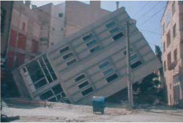
30/3 Dieses solid konstruierte Gebäude ist wie ein starrer Körper umgekippt, die massive Bodenplatte ragt in die Luft. Das Gebäude selbst hat nur relativ geringe Schäden erlitten (Adapazari Türkei 1999).
