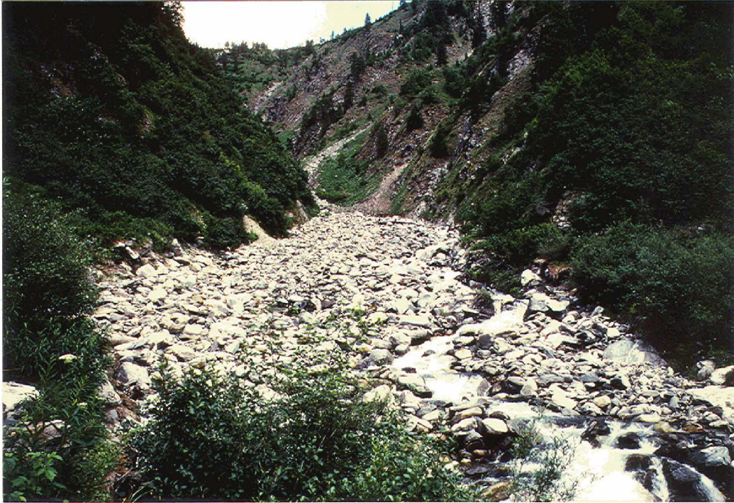
Figur 12 Auflandungen im Ri di Bedretto, Val Bedretto, Ereignis vom 24. August 1987
