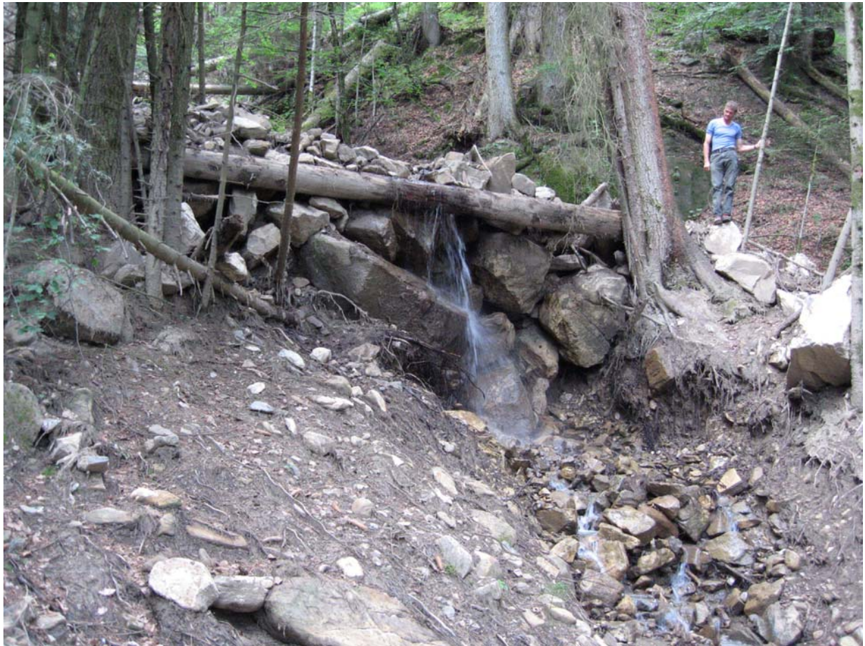
Abb. 12-3: Ein einziger, zufällig verkeilter Baumstamm provozierte eine grössere Ablagerung im Schnellengraben in der Wasserloui/Schatzlibach (Sarnen) während dem Ereignis im August 2005 (Foto: belop gmbh)
