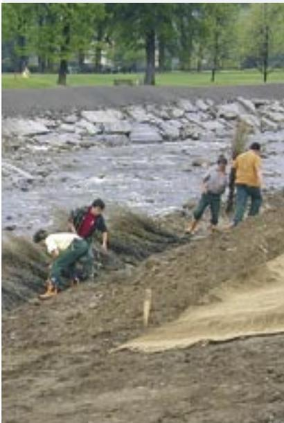
**Wasserbau an der Magliasina TI mit Hilfe von ingenieurbiologischen Methoden.**
