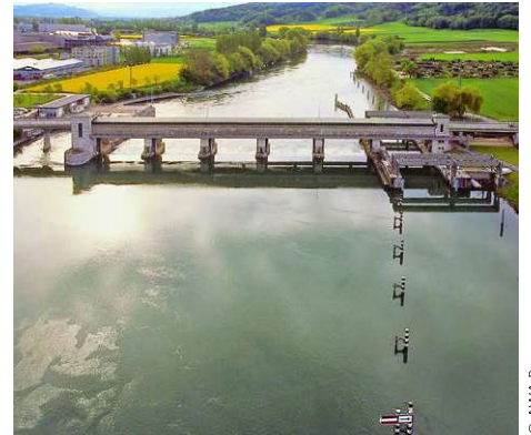
Das 1939 fertiggestellte Regulierwehr in Port ist ein Kernelement der Juragewässerkorrektur. Bei Hochwasser im Einzugsgebiet der Jurarandseen und der Emme lässt sich der Abfluss der Aare hier drosseln. Zum Schutz der Unterlieger werden die Seen in solchen Fällen als natürliche Zwischenspeicher genutzt.
