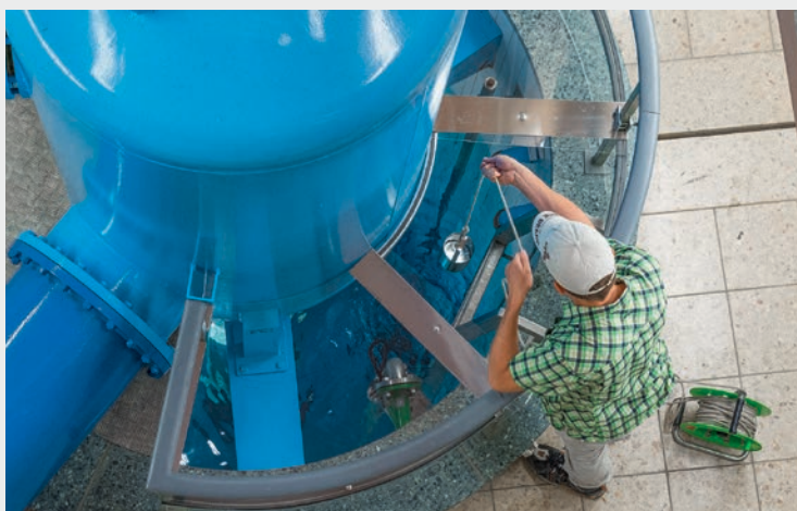
Probenahme in einem Grundwasser-Pumpbrunnen durch einen Mitarbeiter des Amtes für Wasser und Abfall (AWA) im Kanton Bern.
