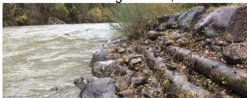
durchlaessig verbaut, steil
