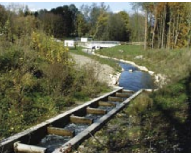
Wasserkraftnutzung im Einklang mit der Natur: Gestaute Aare am Wohlensee BE und Fischtreppe beim Wasserkraftwerk Aarberg BE.
