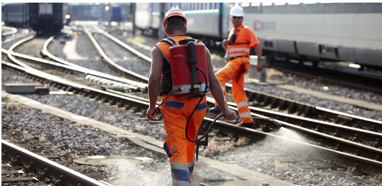
Désherbage des voies ferrées par les CFF
