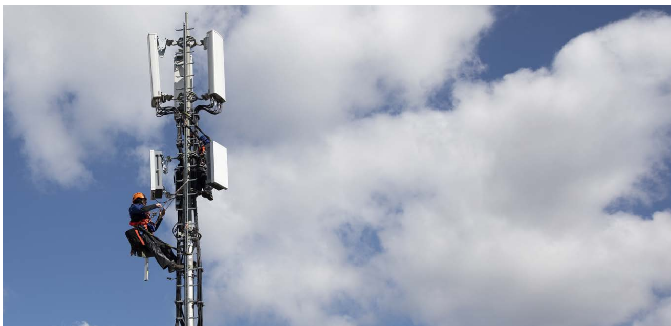
Installation d'une antenne 5G à Berne
