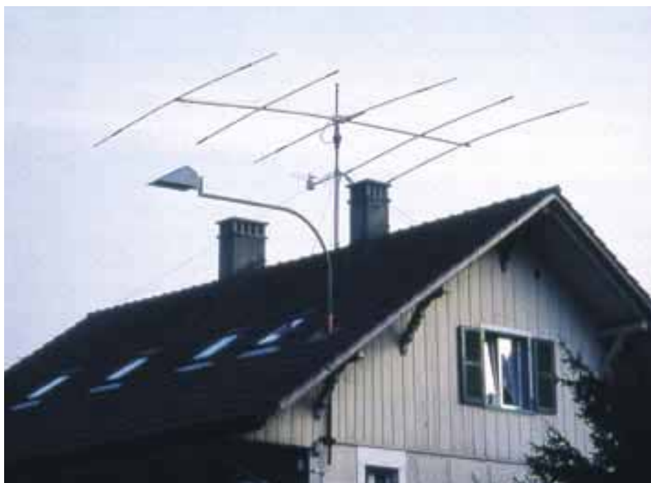
Auf Grund der grossen Typenvielfalt können Amateurfunkantennen sehr verschieden aussehen. Hier ist eine so genannte Yagi-Dachantenne abgebildet.
