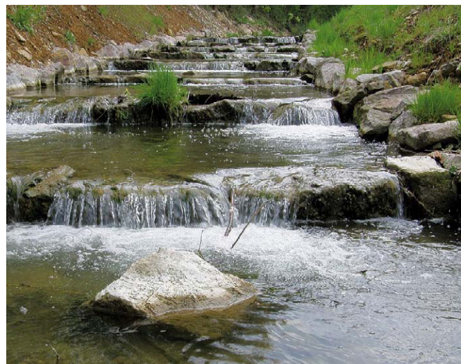
Abb. 4 Vertikale Abstürze bei Querriegeln am Staffeleggbach (AG). In Fließgewässern, in denen die Groppe vorkommt, sollten solche Abstürze vermieden werden. Foto: Denise Weibel
