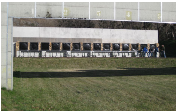
Fig. 30: Installation de tir de chasse à 50m de Rossboden, Coire, installation des PBA derrière l'installation de transport de cibles, photo magma SA, 1.4.2009.
