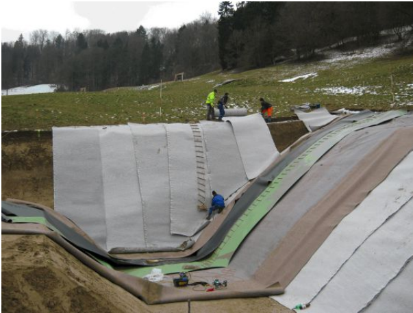
Fig. 35: Installation de tir polyvalente MZA 31, Reppischtal: montage des tapis de drainage et de la feuille d'étanchéité. Photo magma SA, 28.1.2011, aus [18].
