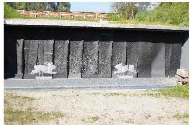
Fig. 27: Caisson de pare-balles en béton à l'arrière de l'installation à segments basculants avec figures animales, [14].
