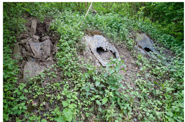
Fig. 20: Installation de tir de chasse Au, Embrach, pare-balles chamois, [30].
