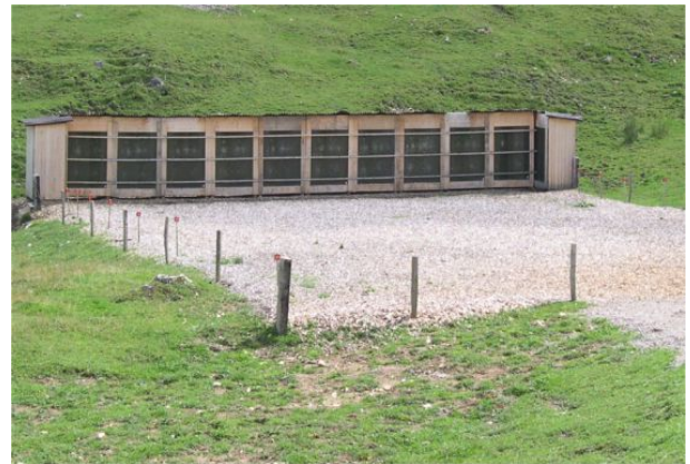
Fig. 33: Caisson en bois sous toit rempli de copeaux de bois sur une place de tir à courte distance, place de tir militaire de Guldentel, SO. De [27].
