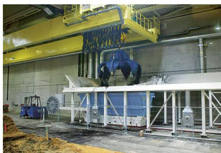
**Sanierung der Sondermülldeponie Bonfol (JU) im Schutz einer hermetisch abriegelten Halle.**
