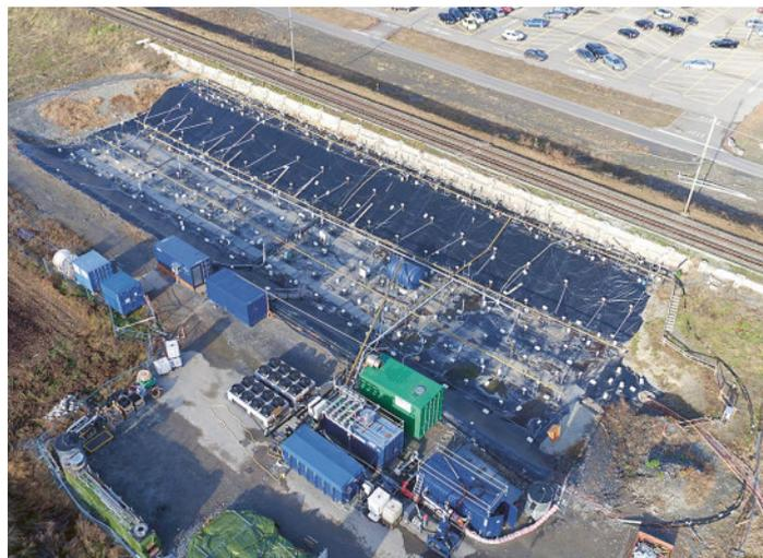
**Nach dem Aushub der Chemiedeponie Pont Rouge in Monthey (VS) wurden die in Boden und Untergrund verbliebenen Schadstoffe mit thermischen Mitteln mobilisiert und unschädlich gemacht.**
