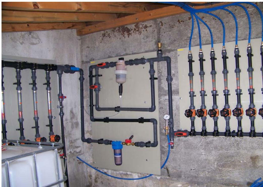
Figure 5: Système de circulation de l'eau avec l'arrivée de l'eau (gauge) et système de distribution de la solution de mélasse (droite).
