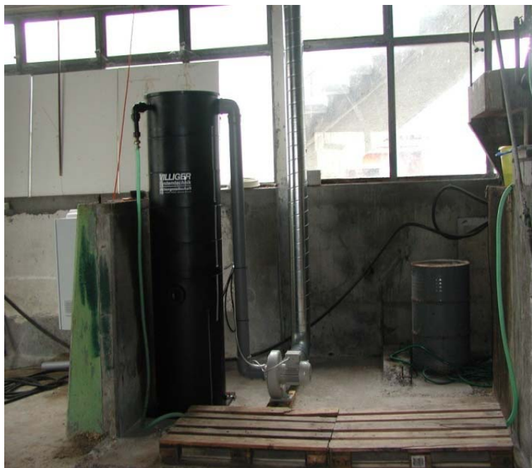
Pompage concentré à partir du foyer de pollution, petite installation env. 1 \text{ m}^3/\text{h} = 17 \text{ l/min}
