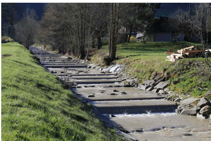
Abb. 19: Kleiner Schwellenvollverbau (Beispiel Steiglebach, Gemeinde Marbach, LU): links Foto, rechts Situationsplan.
