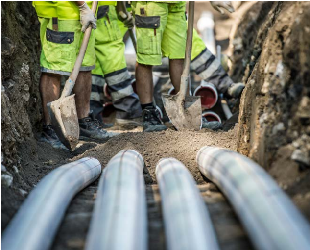
Einsatz von REB® – Ragazer Erdbeton in Chur
