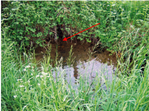
Abb. 3 > Entwässerungsrohr mit anschliessend offenem Graben
