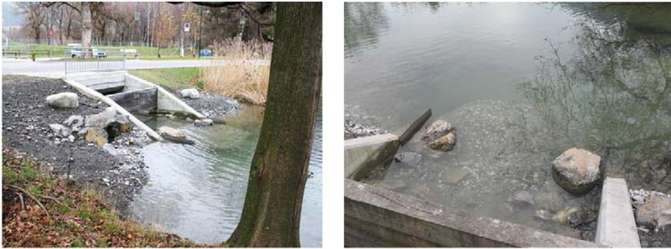
Abb. 8 > Krebssperre beim Auslauf eines Teiches, welche die Abwärtswanderung der Krebse verhindert
