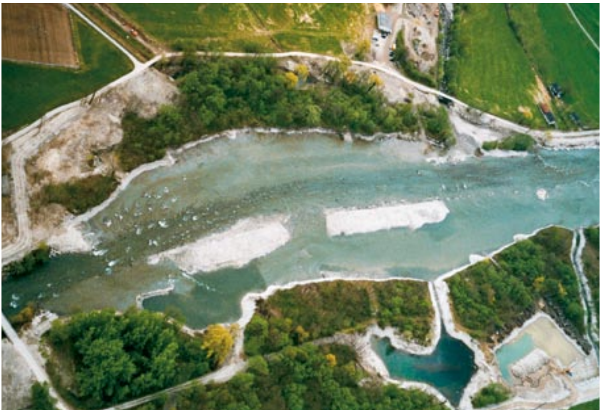
Durch eine einmalige und gezielte Kiesentnahme wurde die Sohle verbreitert, damit die alluviale Dynamik wieder genügend Raum findet: Pascoletto, GR (Foto: Rolf Wyss).
