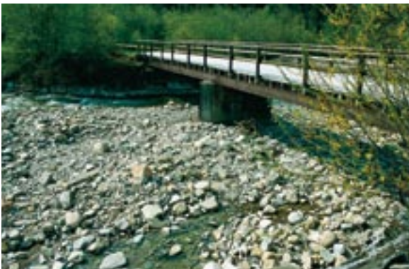
Mit Hilfe eines Kontrollsystems wird der Zeitpunkt der Kiesentnahme zum Schutze der Brücke festgelegt: Aergera, FR (Foto: Martin Jäggi).
