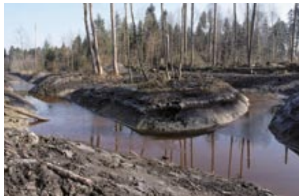
Um neuen Lebensraum für den Biber zu schaffen, wurde ein verlandeter Kanal wieder ausgehoben: Schwarzgraben bei Ins (Foto: Jan Ryser).
