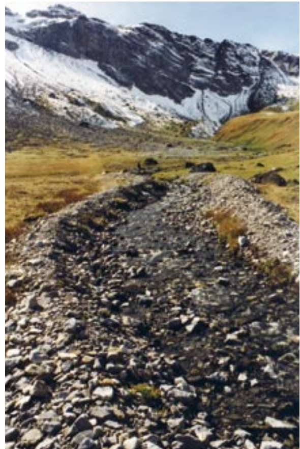
Die Dynamik des Fliessgewässers wurde durch Ausbaggern und Schüttung von Dämmen zum Schutz der Weideflächen beeinträchtigt; Engstligenalp, Nr. 1352 BE (Foto: Auenberatungsstelle)
