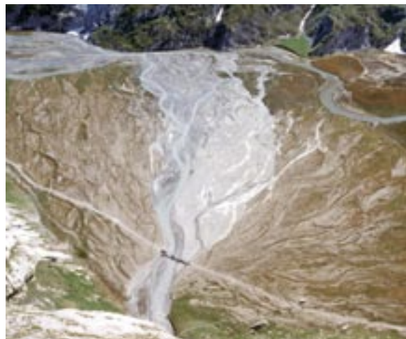
Der Weg zum Segnaspas führt über eine Brücke, die den Dynamikbereich des Baches auf 1/3 seiner ursprünglichen Ausdehnung reduziert; Plaun Segnas Sut, Nr. 1316 GR (Foto: Auenberatungsstelle)
