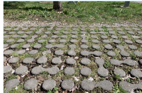
Versiegelte Parkplätze durch Schotter, Schotterrasen oder Rasengittersteine ersetzen, wo Wildkräuter durchaus wachsen dürfen.
