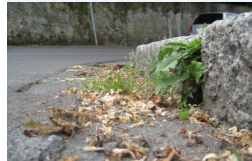
Regelmässiges Wischen verhindert die Ansammlung von organischem Material und schädigt bereits bestehenden Bewuchs.
