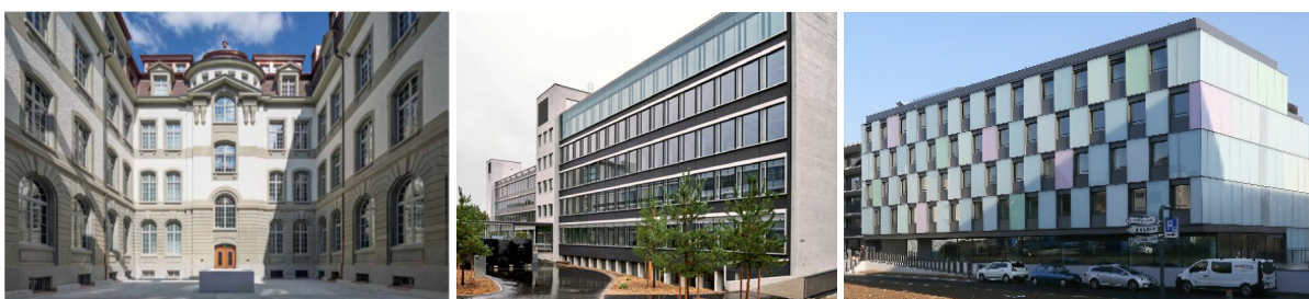
Abbildung 5: Erdbebenschutz bei Bauvorhaben der Bau- und Liegenschaftsorgane des Bundes (BLO) zwischen 2017 und 2020: (links) Erdbebensicherheitsmassnahmen im Rahmen der Instandsetzung des Bundeshaus Nord in Bern, BBL; (Mitte) Erdbebensicherheitsmassnahmen im Rahmen der Sanierung und Aufstockung des Kopfbaus des Laborgebäudes für Biologie HPM auf dem Höggerberg, ETH Zürich; (rechts) Erdbebengerechter Neubau des Studentenwohnkomplexes «Les Triaudes» in Ecublens, EPFL.
