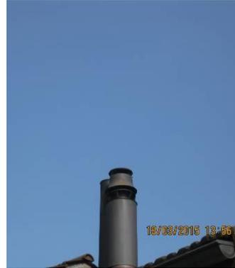
Abbildung 6.6: Minute 28, kein Rauch sichtbar, CO > 8000 mg/m<sup>3</sup>
