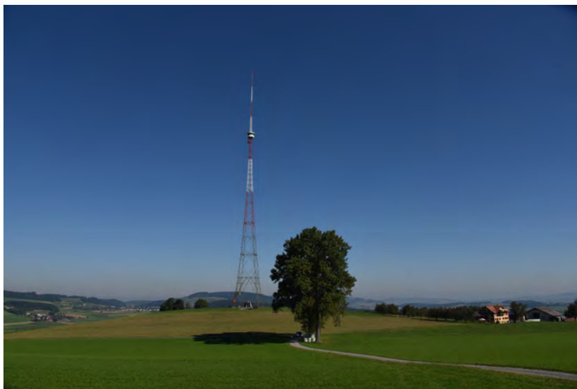
Abb. 2-7: Messstation Beromünster, stillgelegter Sendemast des ehemaligen Landessenders
