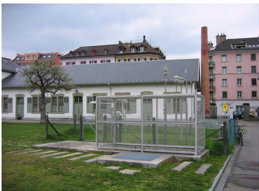
Abb. 2-46: Messstation Zürich (Messstation unterirdisch)
