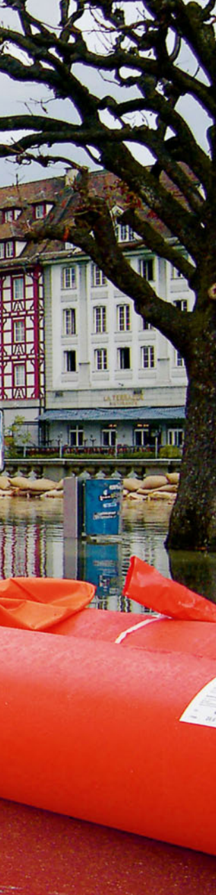
Mobile Hochwassersperren – sogenannte Beaver-Schläuche – entlang der Reuss in Luzern.
