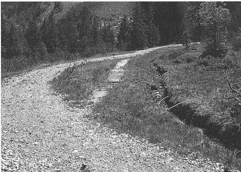
Abb. 7: Neubau eines befestigten Maschinenwegs durch ein Hochmoorbiotop (alter Prügelweg in der Bildmitte). Kalkeintrag aus dem Koffermaterial und Seitenentwässerung führen zur Beeinträchtigung des Moors beidseits des Weges.
