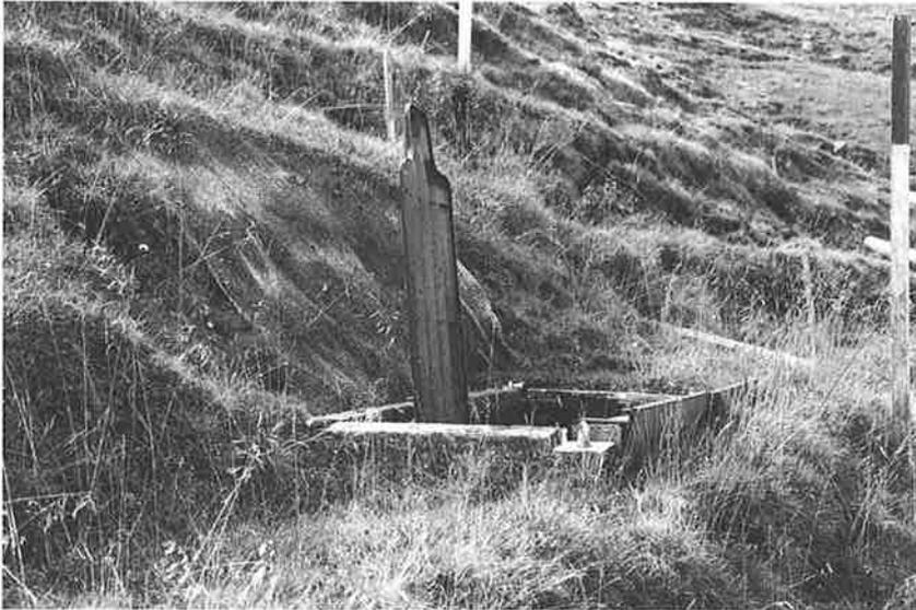
Abb. 2: Frisch eingebauter TAA-Kasten. Der hintere Kugelfang ist mit Jutematten geschützt und der vordere Kugelfang mit Grasziegeln abgedeckt.
