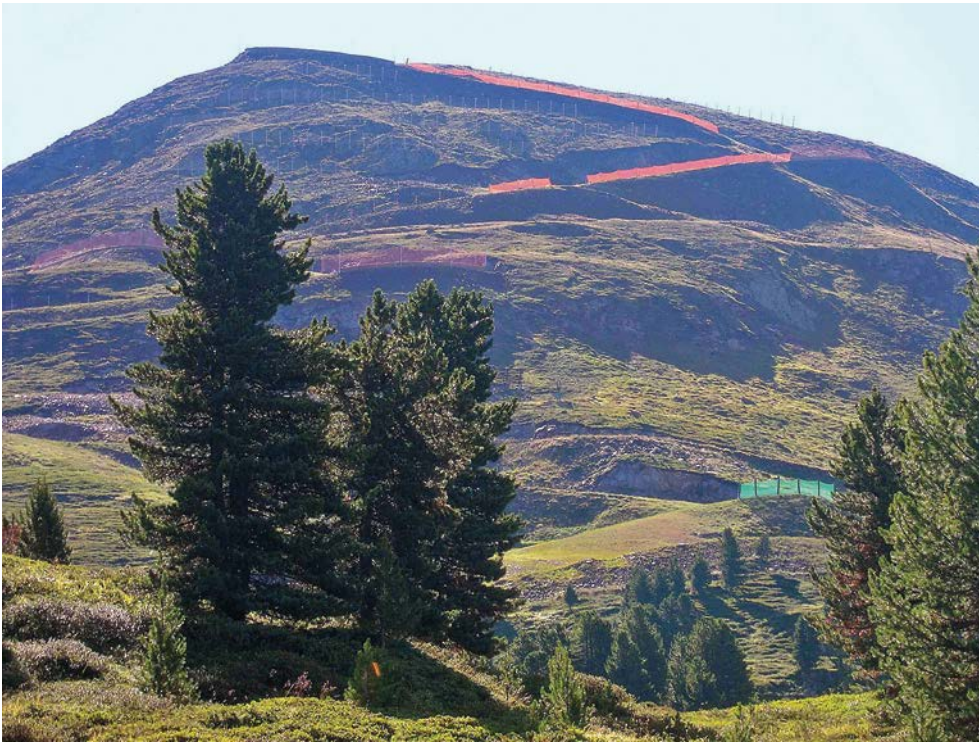
Abb. 54 > Indem die Sicherheitsnetze und ihre Masten entfernt würden, liessen sich die Auswirkungen auf das Landschaftsbild ausserhalb der Betriebszeiten markant verringern.
