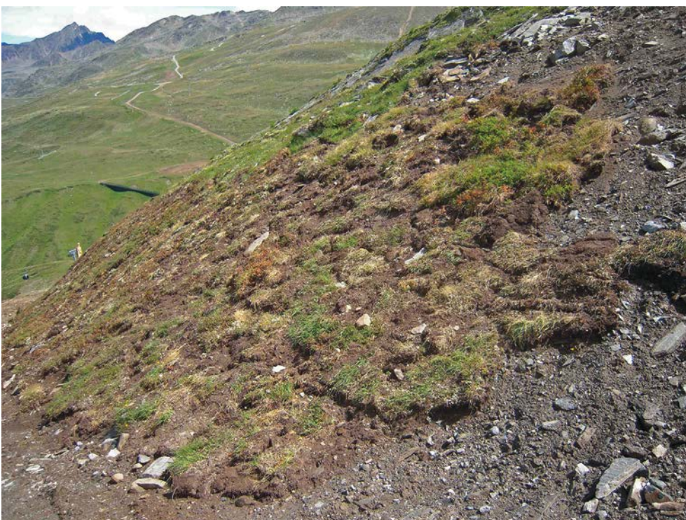
Abb. 60 > Direktbegrünung mit Vegetationsteilen auf der Böschung einer neu angelegten Piste. Allerdings wurden die Soden trotz der starken Neigung nicht befestigt.
