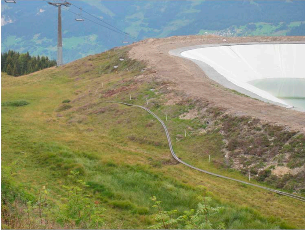
Abb. 10 > Sorgfältige Wiederherstellung nach dem Bau eines Speichersees
