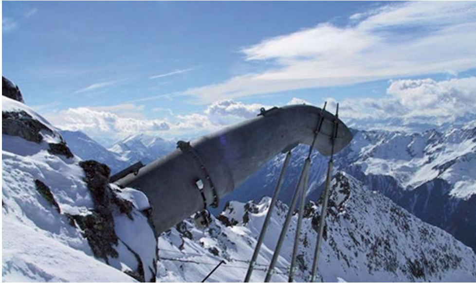
Abb. 13 > Ortsfestes Lawinensprengsystem mit Gasetonation (Gasex-System)
