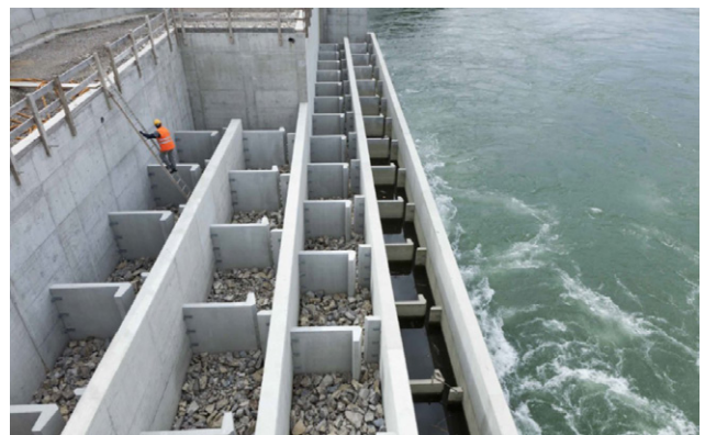
Vertical-Slot-Fischpass mit rauer Sohle im Bau (Bild: Energiedienst)
