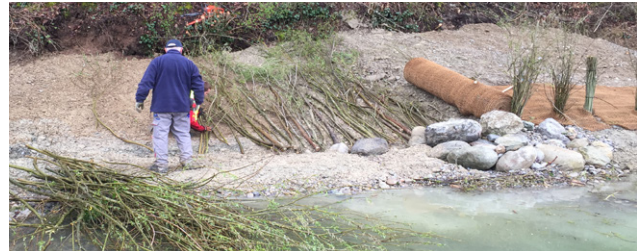
Weidenspreitlagen als Erosionsschutz der Ufer (Bild: Peter Hunziker/SHPower)
