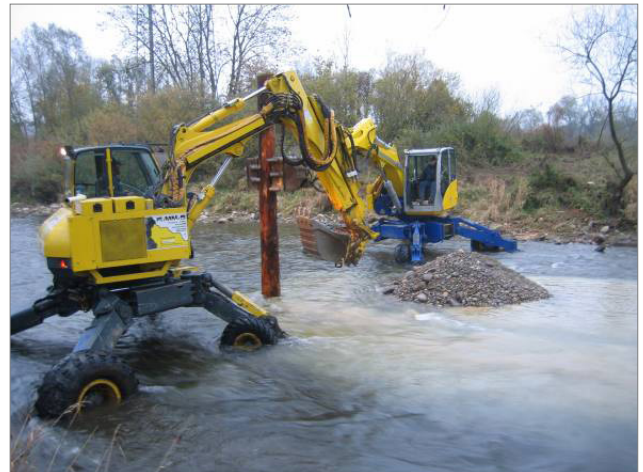
Baumassnahmen bei Vollabfluss in der Wutach: Einbau von Pfählen und Steinbuhnen (Bild: Linsin)
