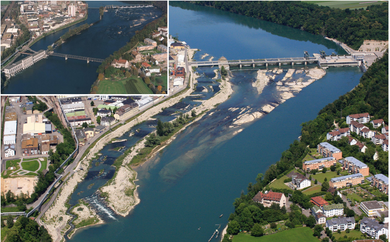
Grosses Foto: Kraftwerk Rheinfelden mit grossem Umgehungsgerinne kurz nach dem Bau; kleines Bild: altes Kraftwerk Rheinfelden (Bild: Energiedienst)
