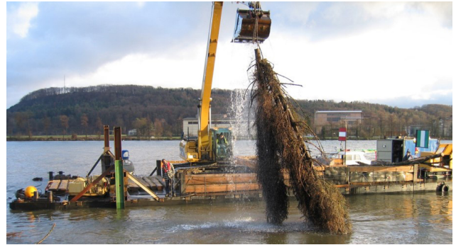
Bau der Totholzinseln durch Verankerung von Raubäumen (Bild: Rheinkraftwerk Albbruck-Dogern AG)
