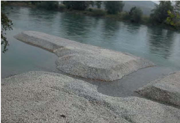
Schüttstelle Zurzach (1 000 m 3 Kies) direkt nach dem Einbau (Quelle: Abegg et. al 2013)
