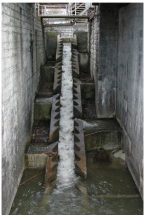
Der alte Denilfischpass (links) wurde durch einen Fischlift (rechts) ersetzt (Bilder: Energiedienst)
