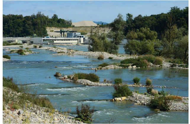
Umgehungsgerinne mit bewachsenen kleinen Kiesbänken (Bild: Energiedienst)
