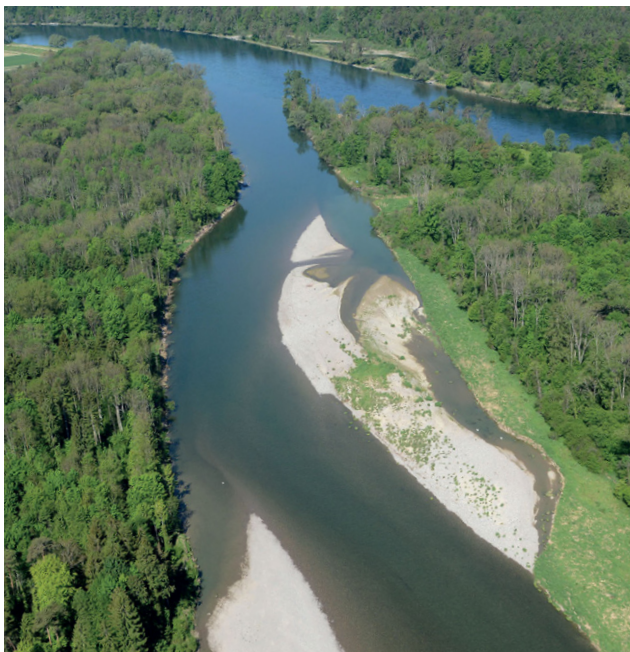
Die Thurnähe mit heute wieder dynamischem Flussbett (Bild: Baudirektion Kanton Zürich)
