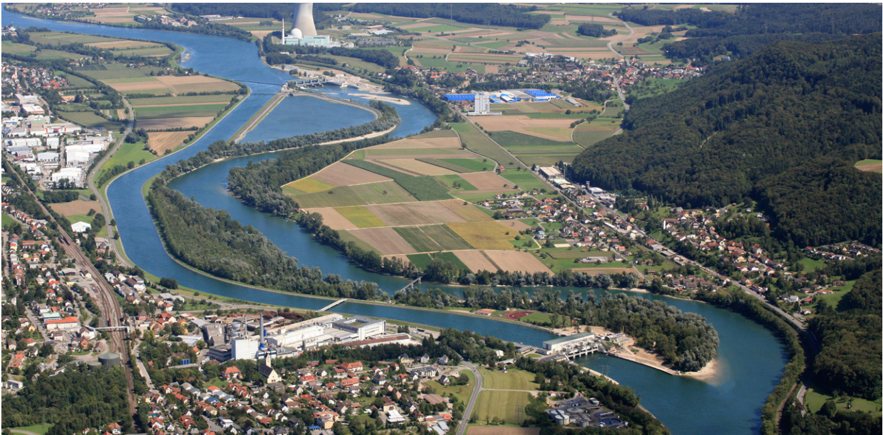
Das Rheinkraftwerk Abbruck-Dogern nach dem Bau des neuen Wehrkraftwerks mit erhöhtem Abfluss im Altrhein (Bild: Rheinkraftwerk Abbruck-Dogern AG)
