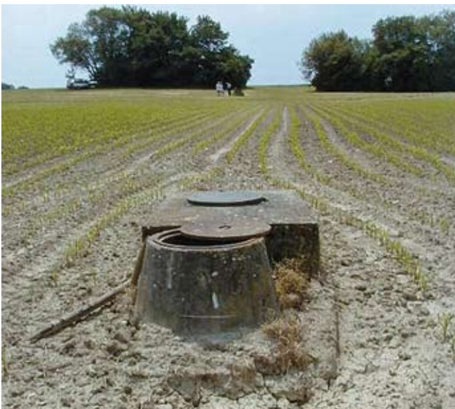
Beispiel einer extrem durch Verschmutzung gefährdeten Grundwasserfassung mitten in einem Maisfeld.
