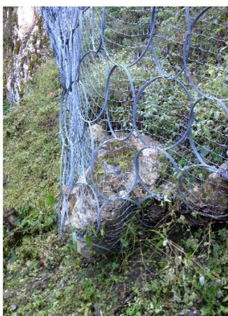
Fig. 1: Sassi e blocchi trattenuti da una rete di protezione (Fonte: Bernard Loup)
