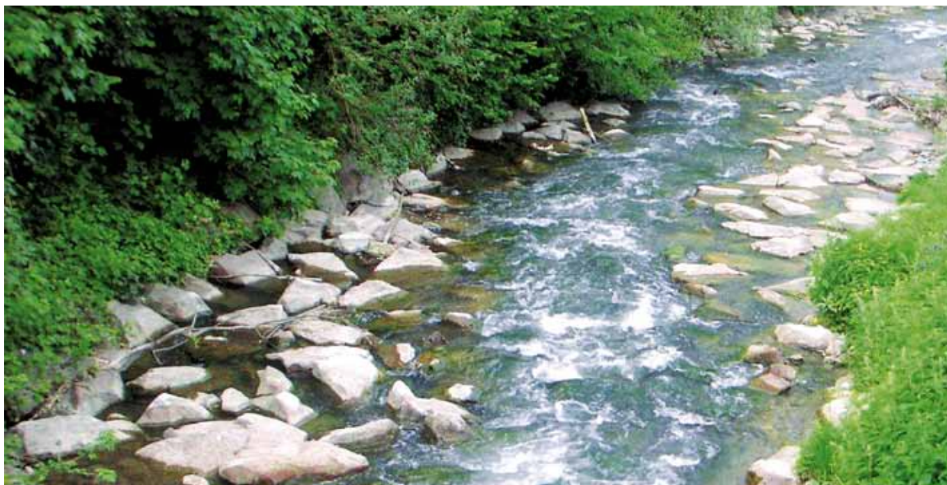
Rampa di blocchi sull'Aabach a Wildegg (AG).
