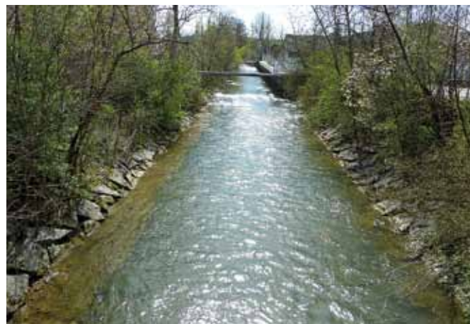
Fig. 1 Alveo canalizzato del fiume Wigger presso Zofingen (AG). Foto: Armin Peter
