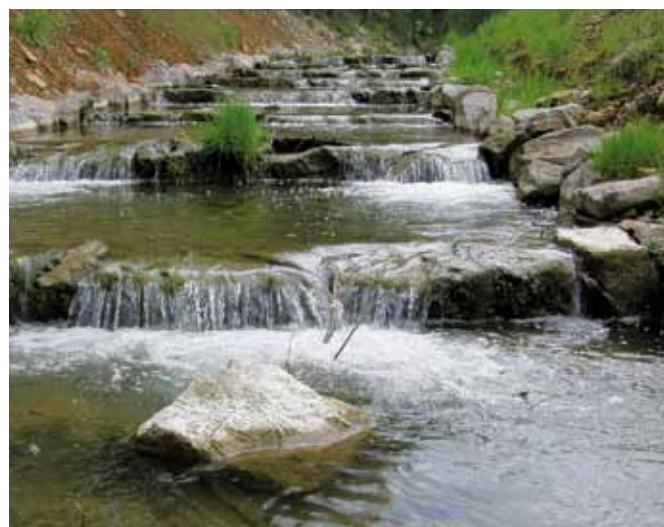
Fig. 4 Scoscendimenti verticali sulle traverse nello Staffeleggbach (AG). Nei corsi d'acqua dove è presente il goppio devono essere evitati questi scoscendimenti. Foto: Denise Weibel
