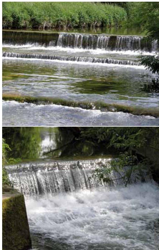
Fig. 1 I gradini sul fondo e le opere artificiali di caduta rappresentano degli ostacoli per le migrazioni dei pesci. Opere a traverse sulla Sissle (AG; in alto) e sulla Suhre (AG; in basso).
