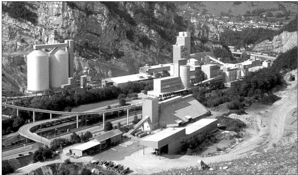
Abbildung 8: Vigier Cement AG, Péry
