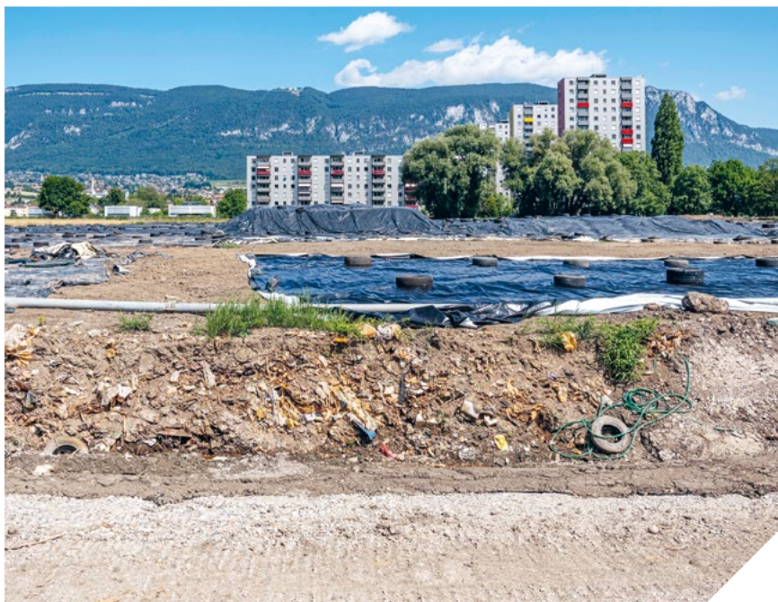
Blick über die Deponie Spitalfeld, die aktuell ausgehoben wird.
