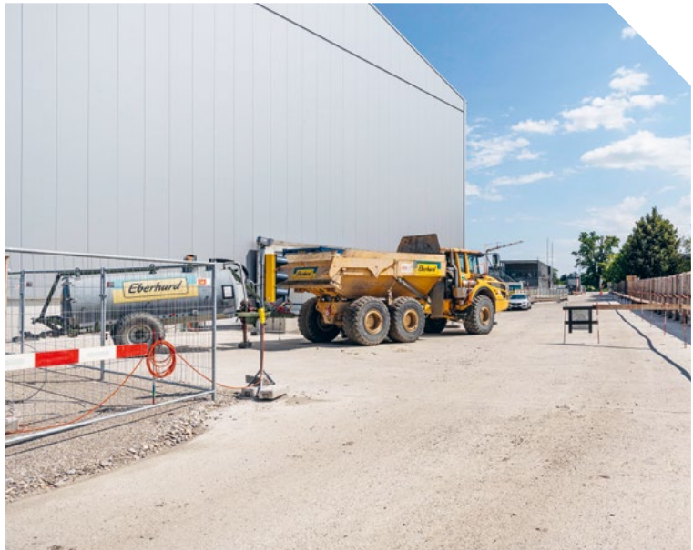
Ein Lastwagen bringt ausgehobenen Abfall zur Behandlung und Entsorgung in die temporäre Anlage auf der Deponie Unterhof – der ältesten der drei Stadtmist-Deponien.
