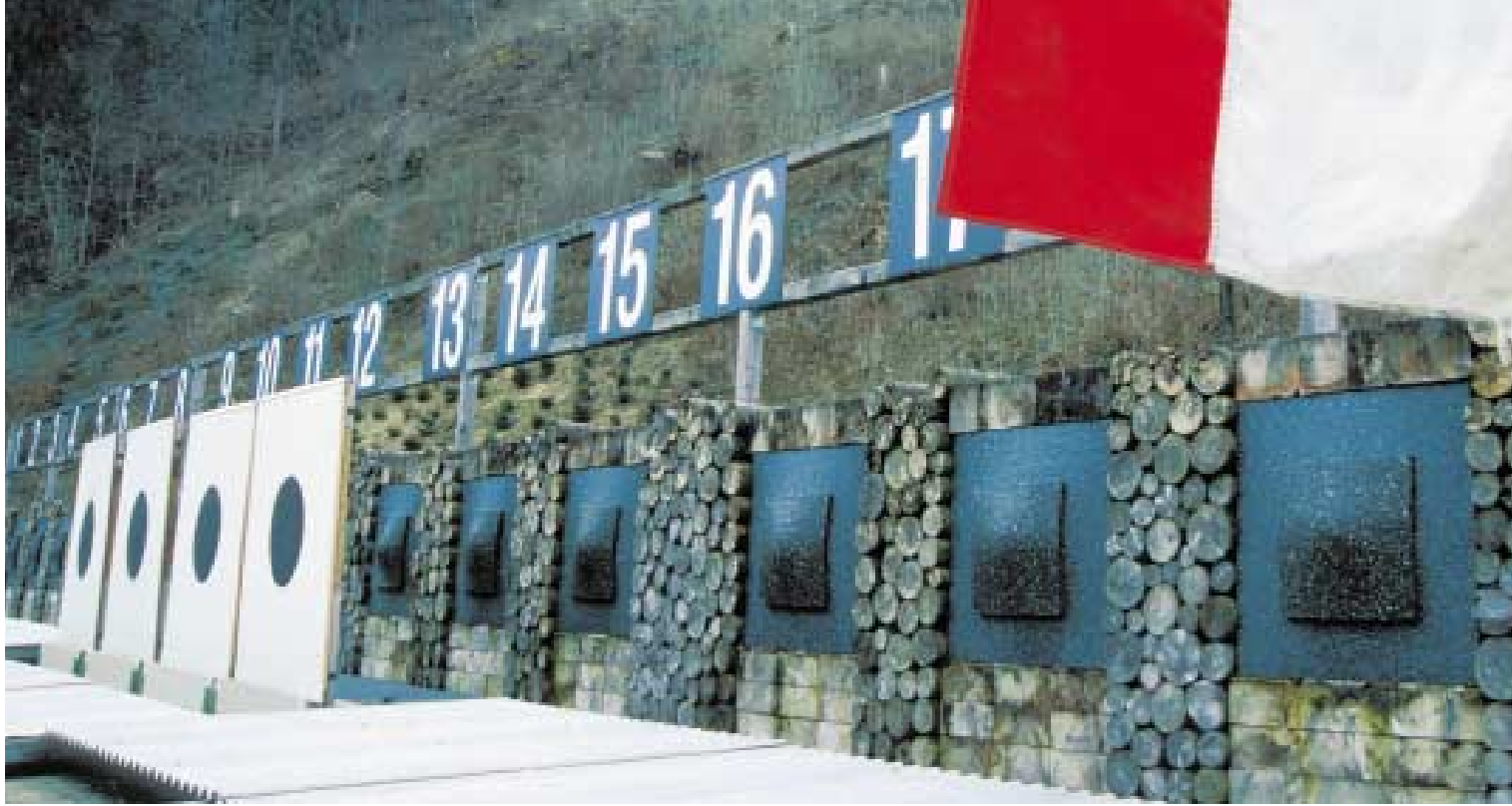
Vorbildliche Schiessanlage der Armee in Walenstadt SG: Die Kunststoffplatten hinter den Zielscheiben fangen die Geschosse auf.
