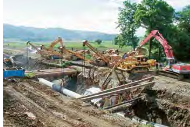
Verlegungsarbeiten im Mittelland
