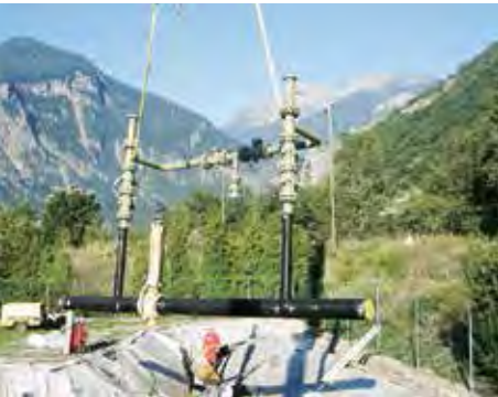
Bau der Schieberstation Martigny (VS)
