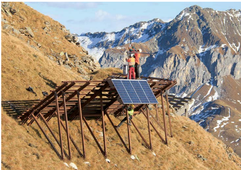
In St. Antönien (GR) soll auf Lawinerverbauungen von 12 Kilometern Länge eines der grossen Solarkraftwerke der Schweiz entstehen. Das Bild zeigt die Montage einer Versuchsanlage.
