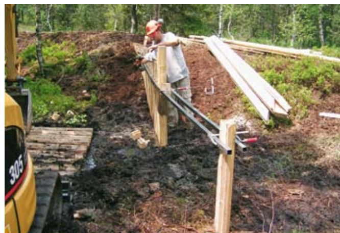
Abb. 102 Metallprofile als Führungsschienen für das Einrammen der Bretter
