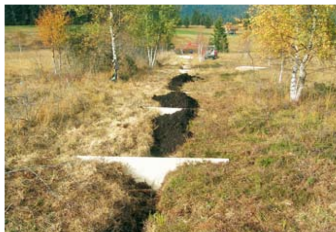
Abb. 89 Mit Platten in regelmässigen Abständen eingestauter und mit Torf verfüllter Graben
