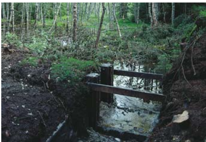
Abb. 108 Wasserregulierung durch einen Holzkasten; die quer zur Abflussrichtung liegenden Bretter bestimmen die Stauhöhe hinter dem Bauwerk; mit zusätzlichen Brettern kann die Stauhöhe der Vegetationsentwicklung angepasst werden.
