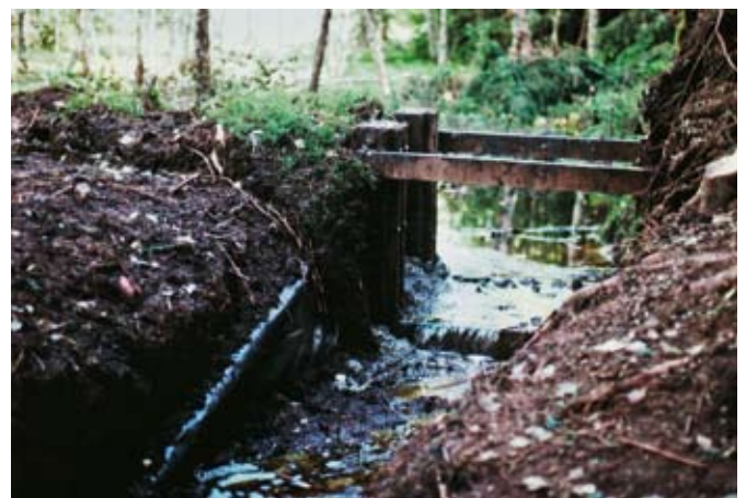
Abb. 108 Wasserregulierung durch einen Holzkasten; die quer zur Abflussrichtung liegenden Bretter bestimmen die Stauhöhe hinter dem Bauwerk; mit zusätzlichen Brettern kann die Stauhöhe der Vegetationsentwicklung angepasst werden.
