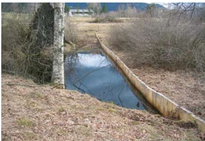
Abb. 104 Fertig eingesetzte Spundwand vor dem Abdecken mit Torf, Walchwil (ZG); Hochmoor Früebüelmoos
