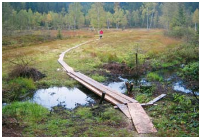
Abb. 15 Steg aus Gerüstbrettern
