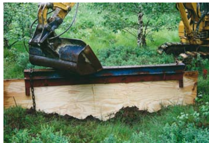
Abb. 75 Einsetzen der Platte und des Metallprofils mithilfe des Kleinbaggers
