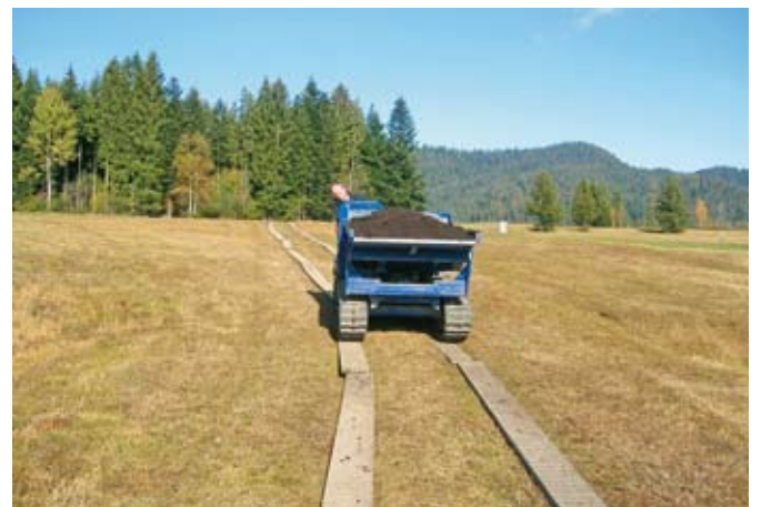
Abb. 16 Holzpasserelle für Fahrzeuge
