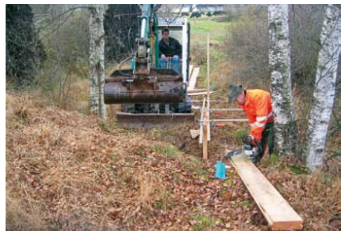
Abb. 103 Abschrägen der Brettspitze mithilfe der Motorsäge
