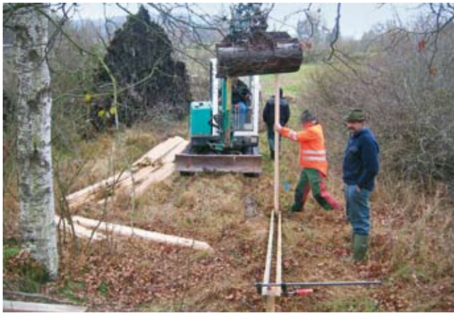
Abb. 101 Einrammen der Bretter mithilfe eines Kleinbaggers
