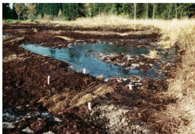
Abb. 56 Mit Kokosmatten ausgelegter Überlauf an einem Torfwall, Eggiwil (BE), Kantonales Naturschutzgebiet Steinmösli
