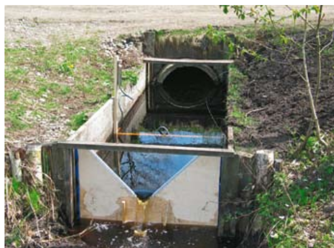
Abb. 12 Normiertes Überlaufwehr
