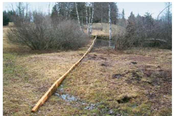
Abb. 105 Mit dieser Methode können sehr lange Dämme errichtet werden.
