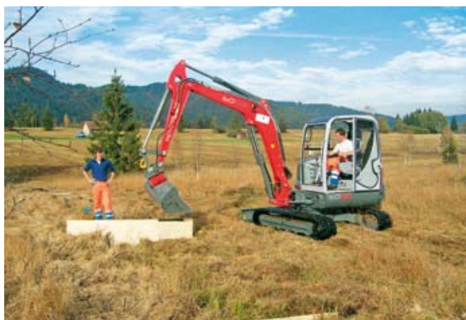
Abb. 88 Einsetzen von Platten, am oberen Ende des Grabens beginnend
