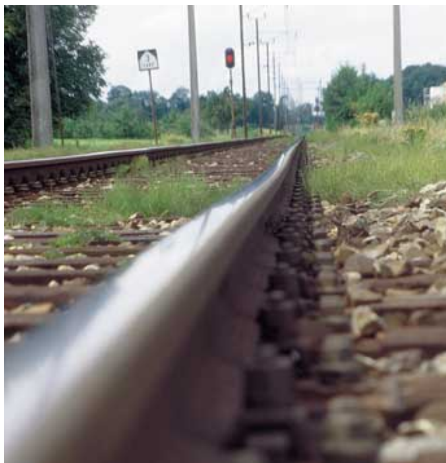
Pflanzen sind ideale Indikatoren für die Beschaffenheit des Bodens: Der üppige Bestand an Schachtelhalm auf dem Bild zeigt, dass der Boden an dieser Stelle vernässt und folglich instabil ist, was schliesslich zur Senkung des Gleises geführt hat!
