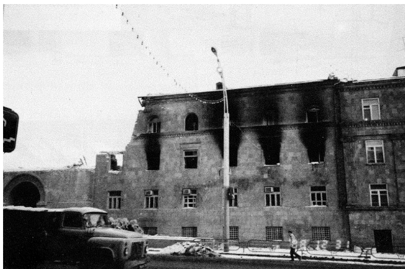
Bild A.4: Spitak-Beben: Gebäude in Leninakan, in welchem Gasbrände aufgetreten sind (aus (5)).
