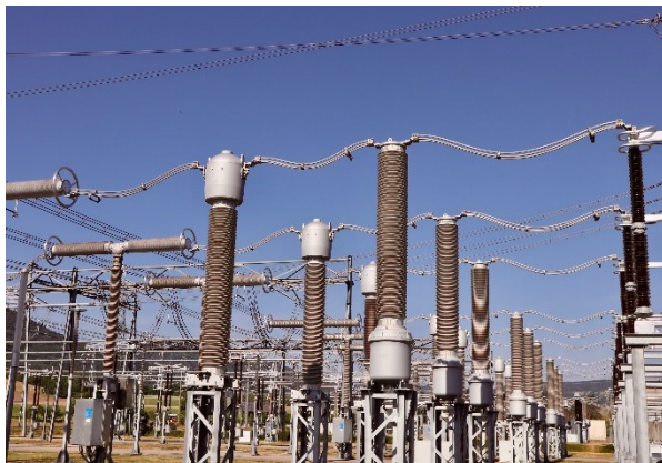
Abbildung 4: Unterwerk Bassecourt (swissgrid) - Links: Erdbebengerechte Leiterverbindungen mit Lose zwischen Hochspannungsapparaten; Rechts: Detail einer erdbebengerechten Rohrverbindung.
