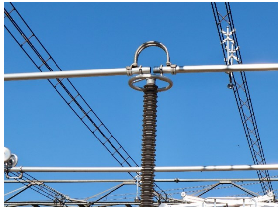
Abbildung 4: Unterwerk Bassecourt (swissgrid) - Links: Erdbebengerechte Leiterverbindungen mit Lose zwischen Hochspannungsapparaten; Rechts: Detail einer erdbebengerechten Rohrverbindung.
