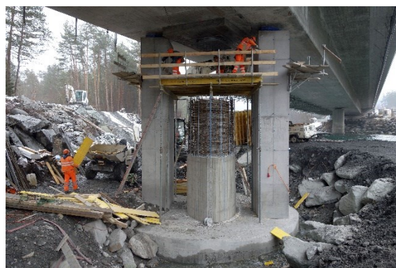
Abbildung 3: Im Rahmen der Verbreiterung der Autobahnbrücke über den Hinterrhein bei Cazis (GR) wurde auch die Erdbebensicherheit verbessert (© Bänziger Partner).
