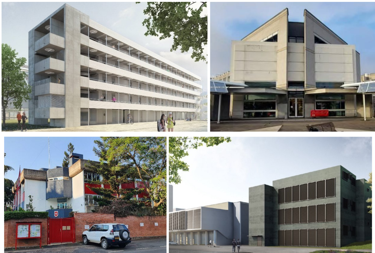
Abbildung 2: Erdbebenschutz bei Bauvorhaben der BLO, Massnahmenperiode 2021 bis 2024: (oben links) Erdbebengerechter Neubau des Sportzentrums in Tenero TI, BBL; (oben rechts) Überprüfung der Erdbebensicherheit des Gebäudes MXF in Ecublens VD, EPFL; (unten links) Überprüfung der Erdbebensicherheit des Kooperationsbüro in Kigali (Ruanda), BBL; (unten rechts) Erdbebengerechte Bemessung des Neubaus des Rechenzentrums, ETH Zürich.
