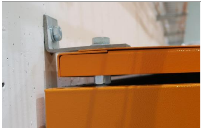
Sicherung eines Schrankes (Bild BAFU)
