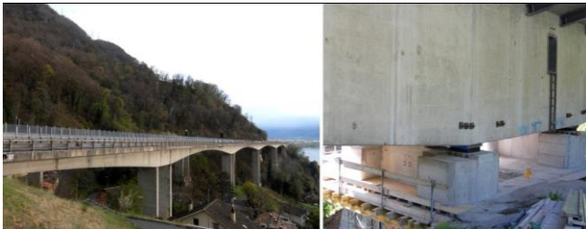
Erdbebensicherheitsmassnahmen, Viadukt Chillon (Bild T. Wenk)
