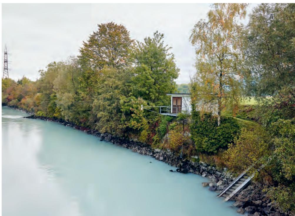
Die Station Porte-du-Scex oberhalb der Rhonemündung in den Genfersee: Die Rampe vorne rechts führt zur Tauchpumpe und verschiedenen Sensoren im Fluss.
