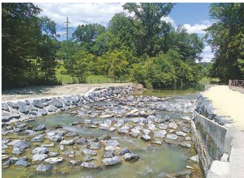
An der Venoge, die westlich von Lausanne in den Genfersee mündet, ist im Sommer 2012 ein bestehendes Wanderhindernis bei Cossonay und Penthaz (VD) durch eine fischgängige Rampe ersetzt worden (Situationsplan oben und Bild nach der Realisierung). Das schwache Gefälle und die zahlreichen Untiefen erleichtern der Seeforelle den Aufstieg in neue Laichgebiete.
