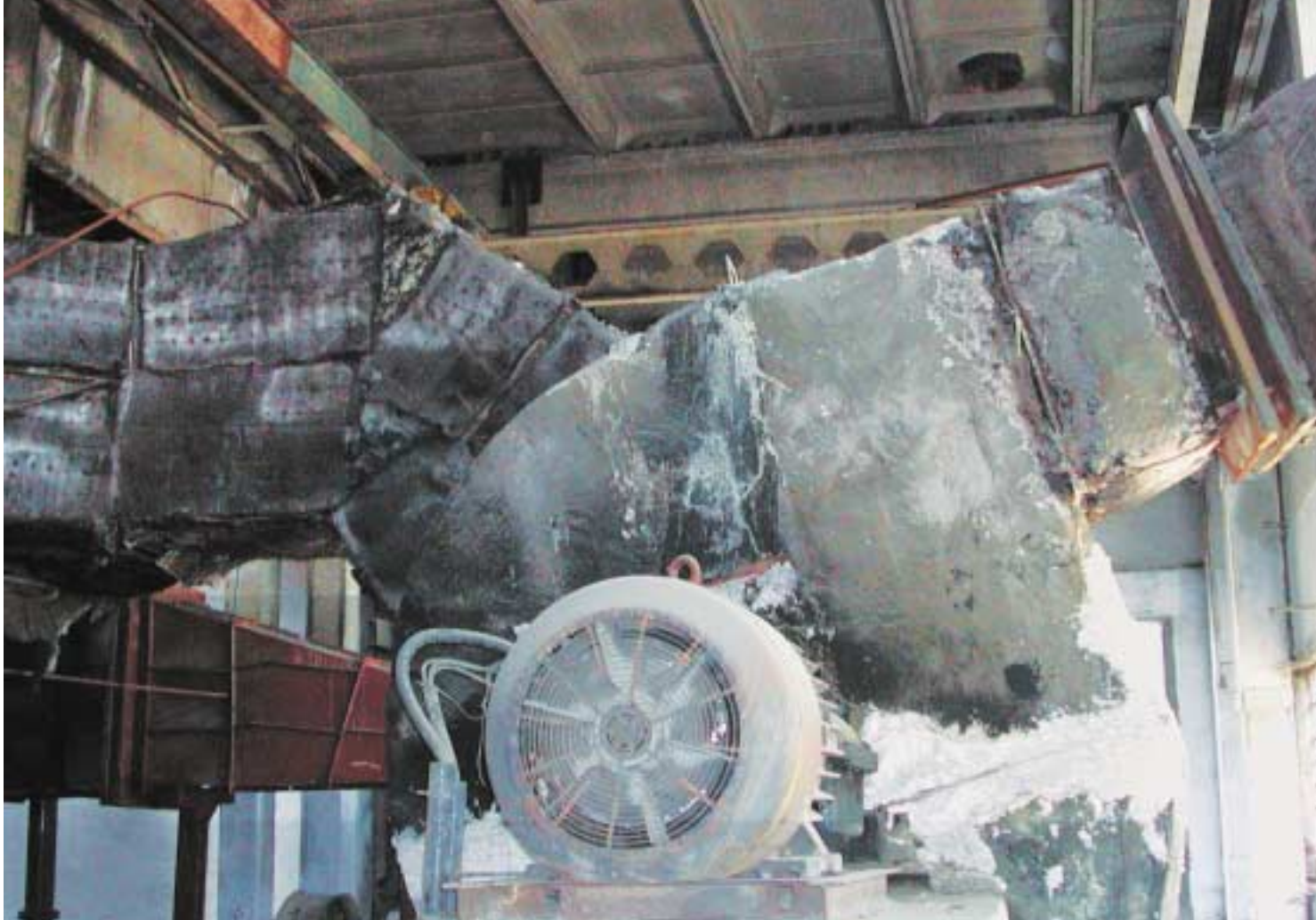
Ein Fernwärmeheizwerk in Andijan, Usbekistan, wird mit Schweizer Hilfe saniert.
