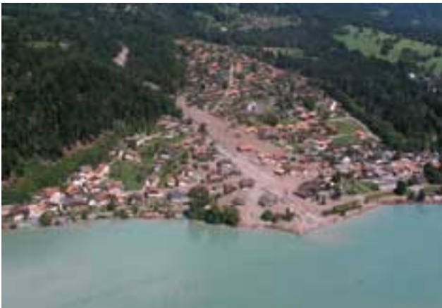
Figur 5: Übermurter Wildbachkegel des Glysibachs in Brienz, nach den Unwettern vom August 2005.
