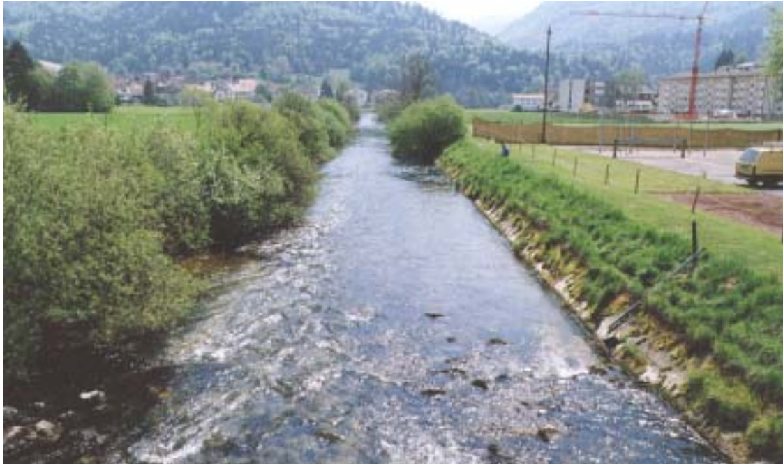
Versuchsstrecke Suze - Sonceboz mit Grenzwertpegel am rechten Ufer, in Fließrichtung betrachtet. Abflussmenge 2.4 \text{ m}^3/\text{s} , Aufnahme vom 18.5.1989
