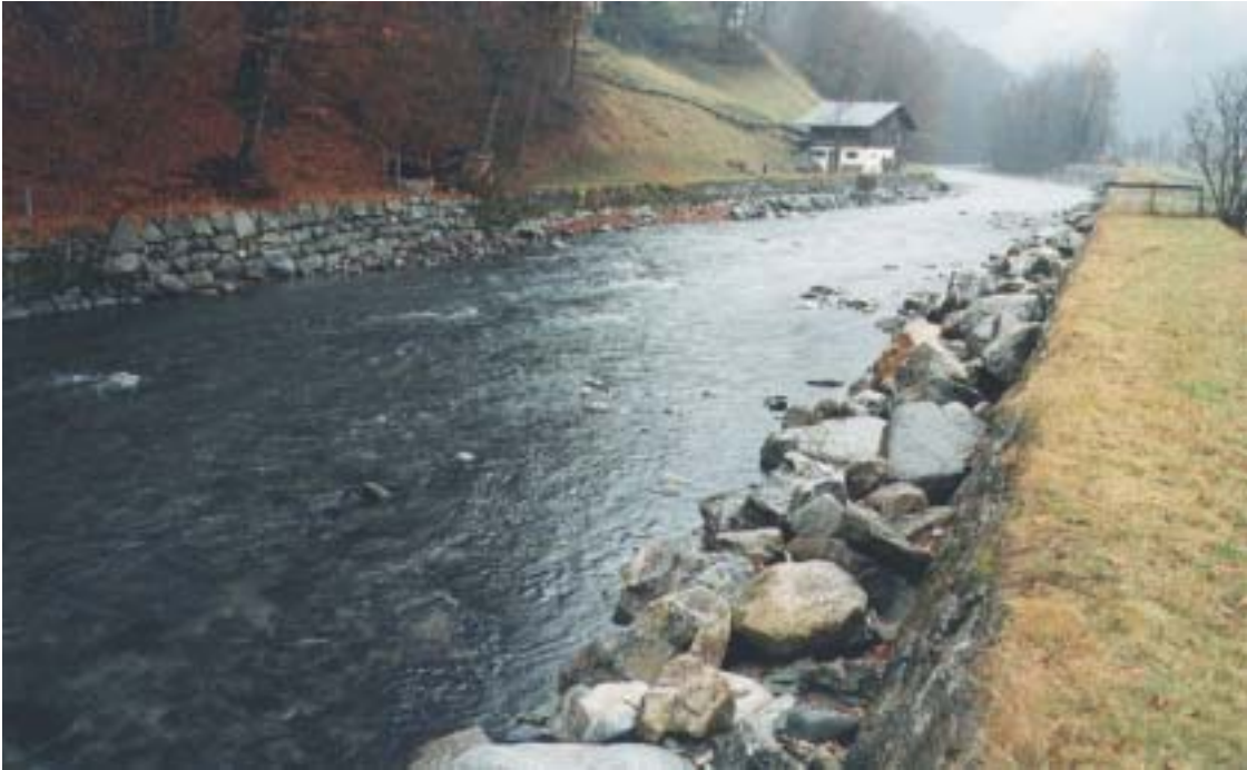
Versuchsstrecke Lütschine - Gsteig, gegen die Fließrichtung betrachtet. Abflussmenge 4.3 \text{ m}^3/\text{s} , Aufnahme vom 8.12.1993
