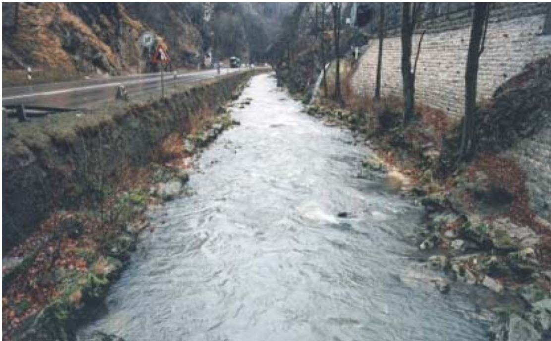
Versuchsstrecke Birse - Moutier, in Fließrichtung betrachtet. Abflussmenge 2.6 m 3 /s , Aufnahme vom 8.12.1993
