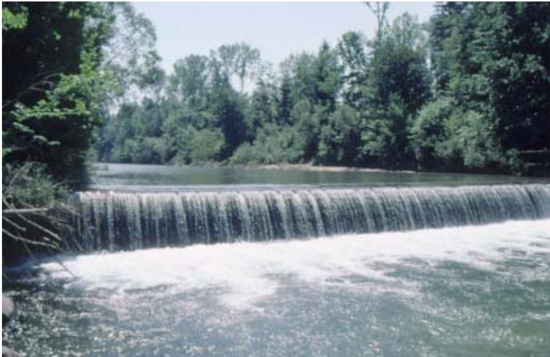
Untere Sperre der Versuchsstrecke Emme - Burgdorf, gegen die Fliessrichtung betrachtet. Abflussmenge 2.1 m 3 /s, Aufnahme vom 20.6.2000
