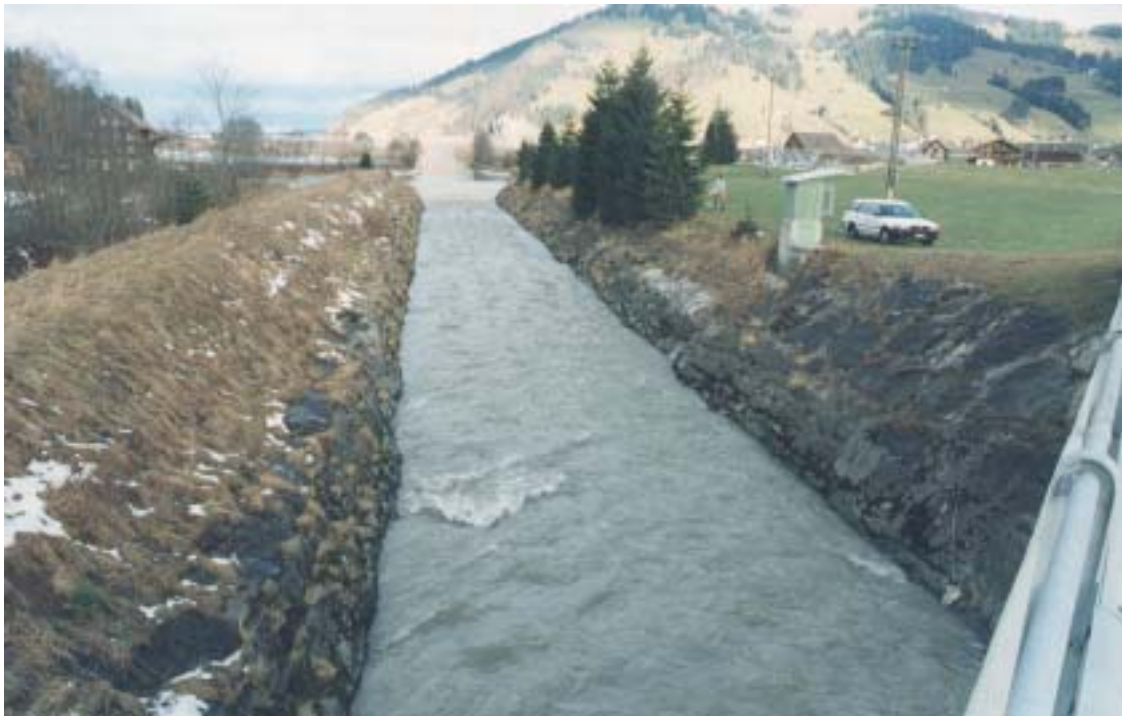
Versuchsstrecke Minster - Euthal, in Fließrichtung betrachtet. Abflussmenge 5 m 3 /s, Aufnahme vom 9.12.1993
