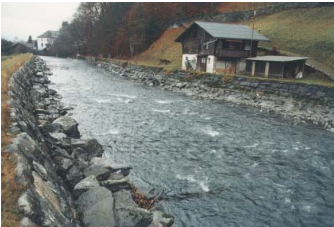
Versuchsstrecke Lutschine -Gsteig in Fliessrichtung mit 4.3 m 3 /s, 8.12.1993
